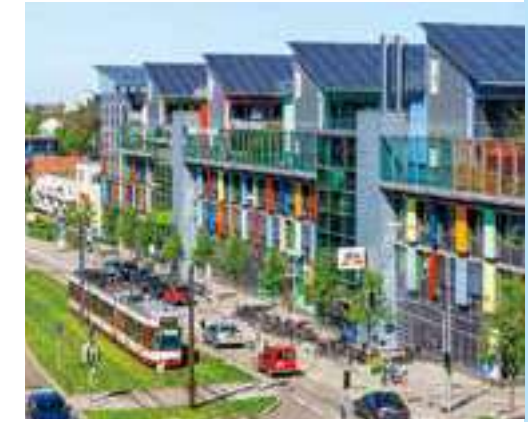
↑6 環境先進都市とよばれるフライブルクの住宅街(ドイツ、2015年) 住宅の壁には熱を逃がしにくい断熱材が用いられ、屋根には太陽電池が設置されている。
